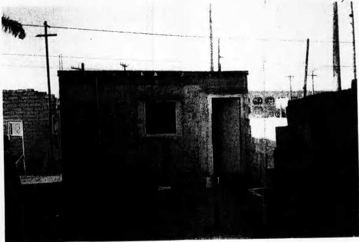
FOTO 3: Parte dos fundos da construção existente na frente do imóvel, utilizada como escritório pela construtora do Hospital.
